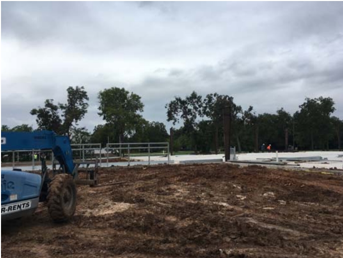
9. PEMB column erection
