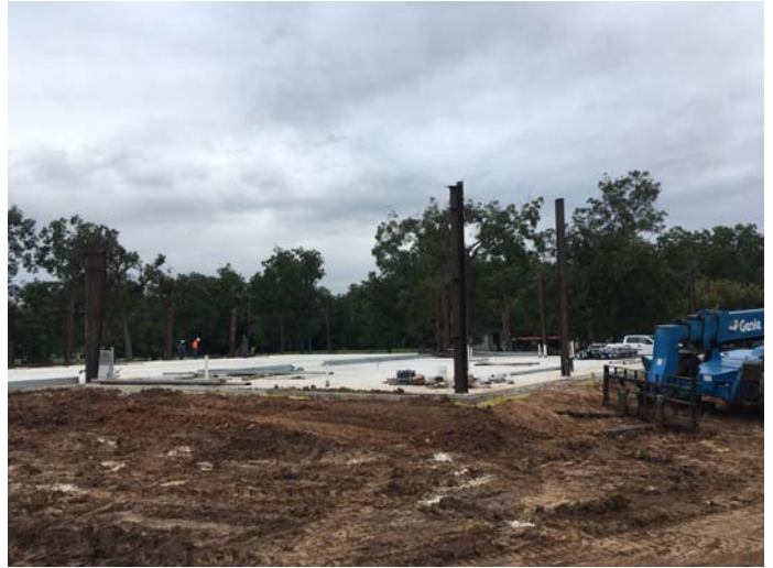
8. PEMB column erection
