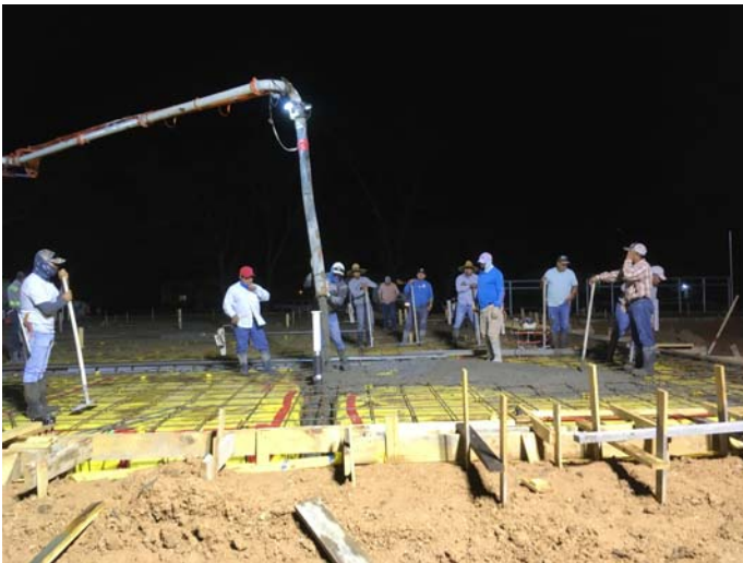
3. Concrete pour at slab on grade
