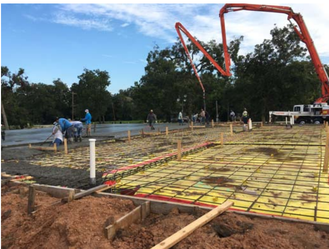
5. Concrete pour at slab on grade
